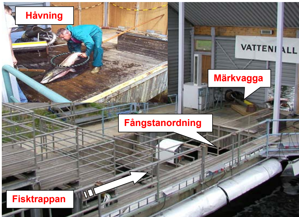
Bild 2. Visar fångstanordningen vid översta steget i Norrfors fisktrappa. Samtliga fiskar som passerar lyfts upp av fiskodlingspersonalen.
